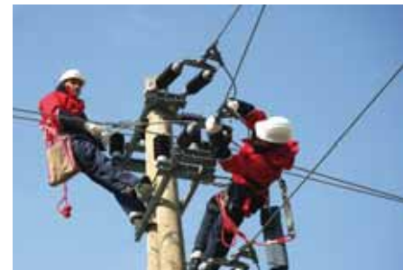
Freileitungsmonteur bei der Arbeit.
