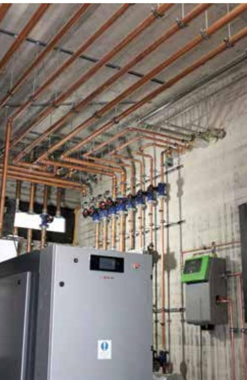
Brennwertgerät (oben), Deckenstrahlplatten (oben rechts), cuprotherm-Fußbodenheizung mit CTX-Rohren (allgemeines Produktbild, rechts).
