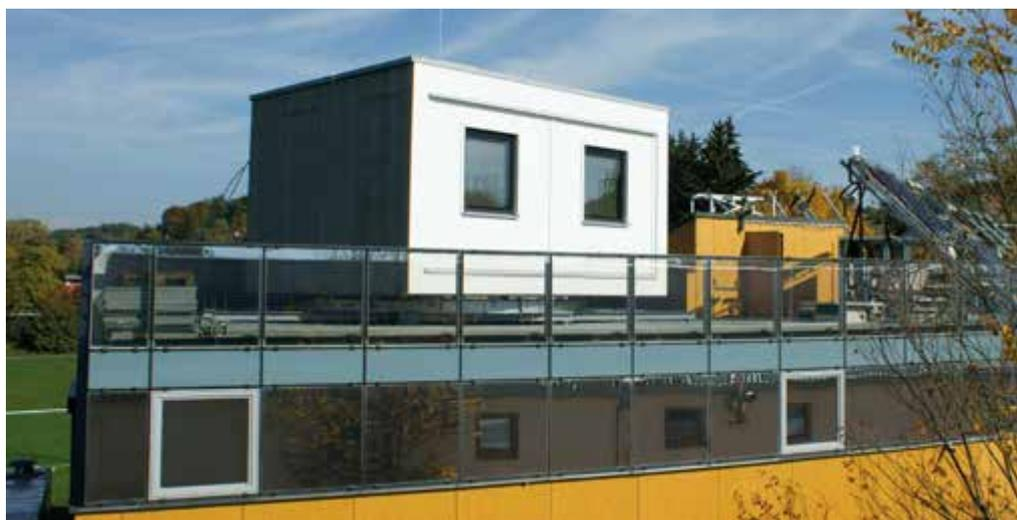
Test- und Prüfboxen für Fassaden und Fassadenelemente der Zukunft angeordnet am Dach des Prüflabors von AEE Intec.
