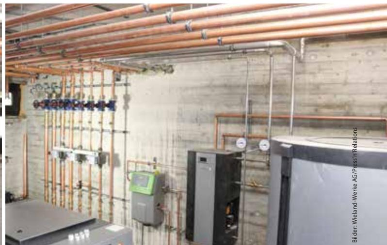
Pufferspeicher, angebunden mit SANCO-Kupferrohren. Bild rechts: Blick in die Heizzentrale.
