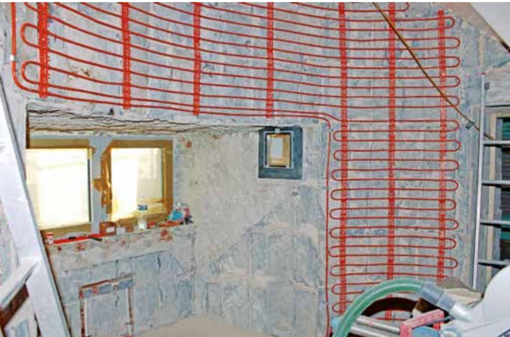
Das Obergeschoß erlaubte keine zusätzlichen Aufbauhöhen am Fußboden, weshalb eine verputzte Wandheizung (65 m<sup>2</sup> EasyFlex von Variotherm) gewählt wurde.
