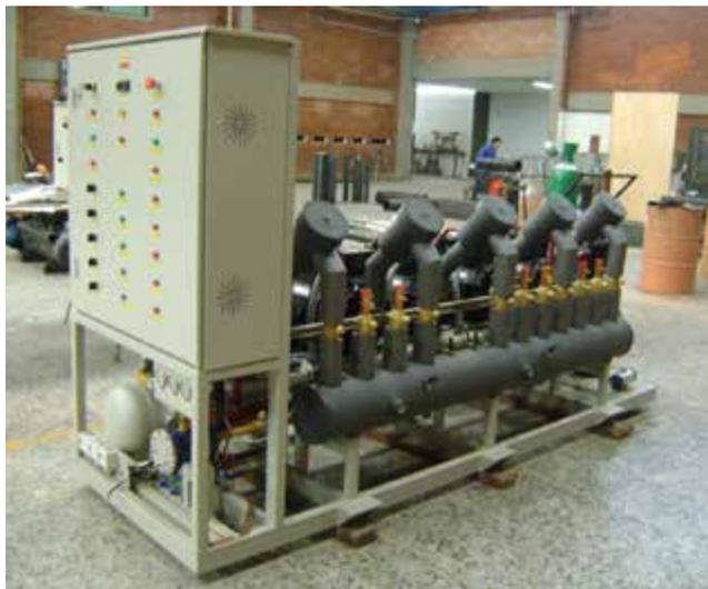
Spannungsrissskorrosion ausgeschlossen: Bei dieser Kälteanlage wurde darauf geachtet, einen Wasserdampfdiffusionsschutz auch an allen Nähten und verklebten Teilen sicherzustellen. Dadurch wird Kondensation unter der Isolierung vermieden.
