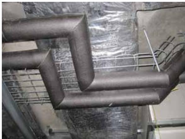
Wenn flexibler Polyethylen-Schaum verarbeitet wird, ist eine spätere Spannungsrissskorrosion nicht zu erwarten. Denn bei der Herstellung des Dämmstoffs werden physikalische Treibmittel eingesetzt, die keine Rückstände im Schaum hinterlassen.
