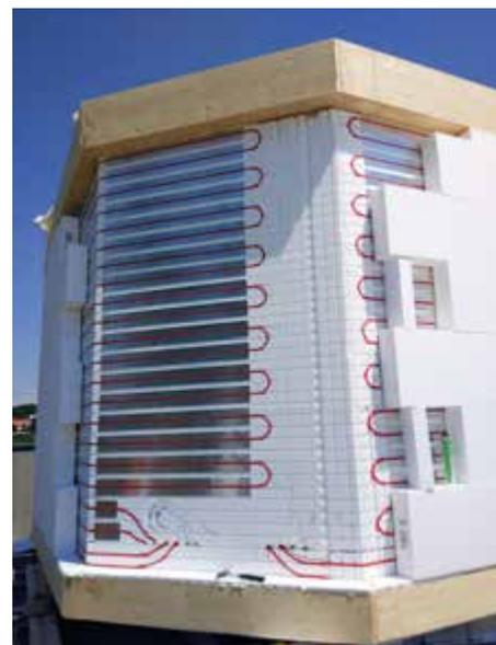
Außenansicht der Test- und Prüfboxen für Fassaden und Fassadenelemente in der Bauphase. Deutlich ist die äußere hydraulische Kompensationsebene zwischen zwei Dämmschichten zu erkennen.
